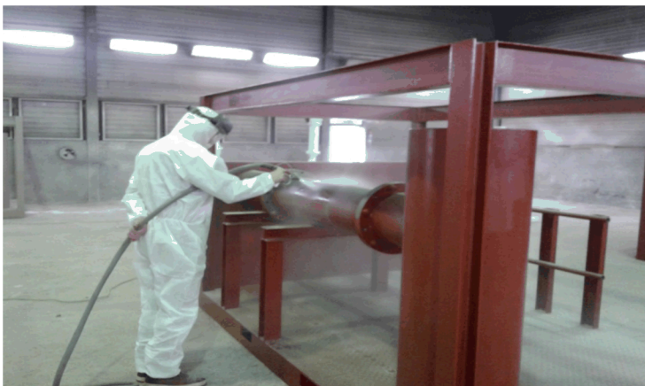
Dimensie nevel uitbreiding (stralen op testopstelling)
